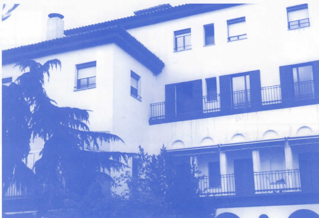
Terrazas de las futuras aulas
