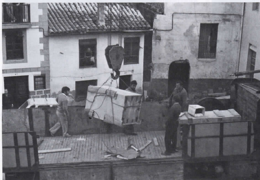
La estatua es descargada del camión que la transportó hasta Oña. Eladio, atento a toda la maniobra.
