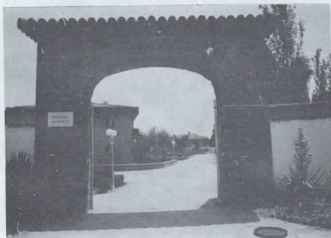
Acceso a la finca "Santa Rosalía", donde se encuentra instalada la Residencia "Santa M.ª del Silencio".
