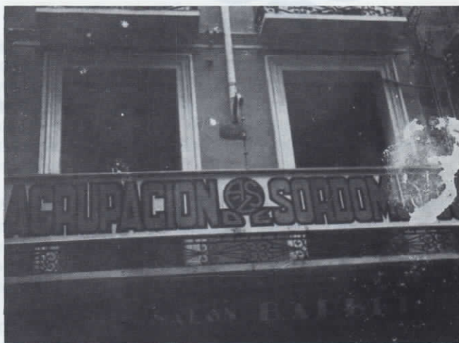
Vista de la fachada del primer local de la A. S. Z. en la C/. Palomeque.
