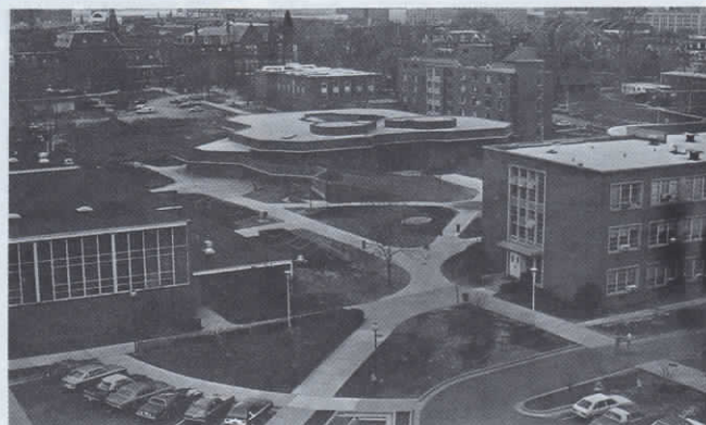
Modernos pabellones. Parkings, y en el centro la moderna cafetería-restaurante de auto-servicio.
