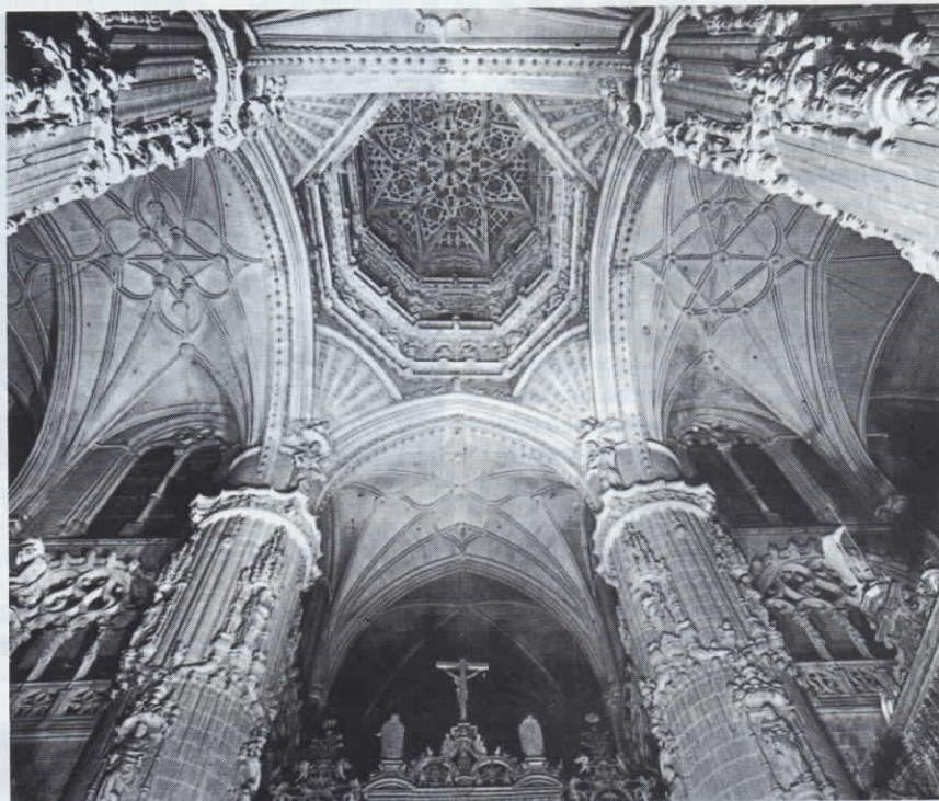
Bóveda de la Catedral de Burgos (Gótico).
