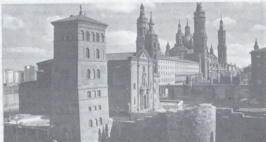
Conjunto monumental: en primer término el torreón de la Zuda y las murallas romanas.
