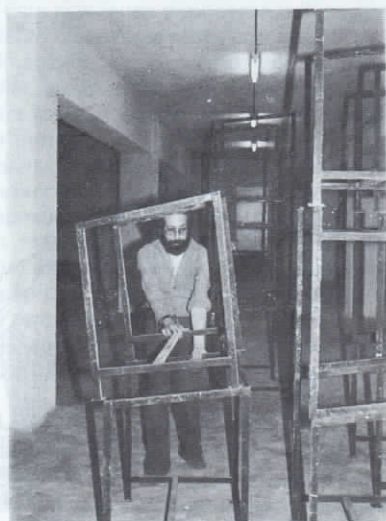
Eduardo Camacho formando estructuras de hierro en uno de los espacios, y que juegan un papel muy importante en el proyecto.
