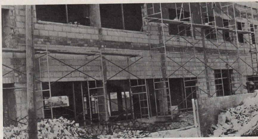
Obras del que creemos será nuestro Centro (Centro Piloto de la Comarca)
